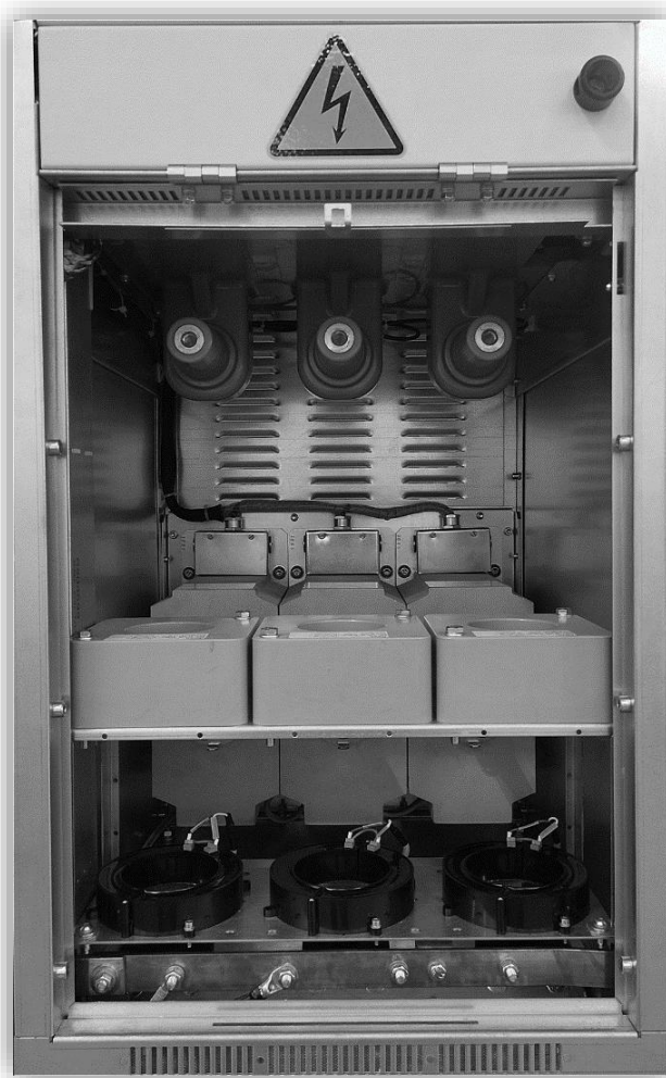
Rys.6.7. Przedział kablowy
