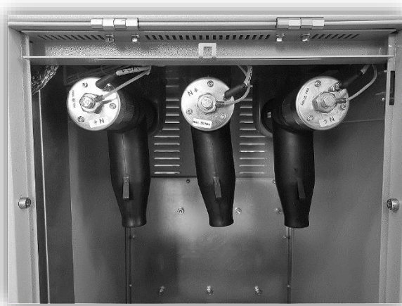
Rys.6.8. Złącza typu C z czujnikami napięcia (przykład)
